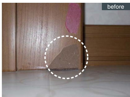
枠剥がれ補修
