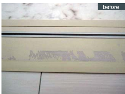
敷居塗膜剥がれ補修
