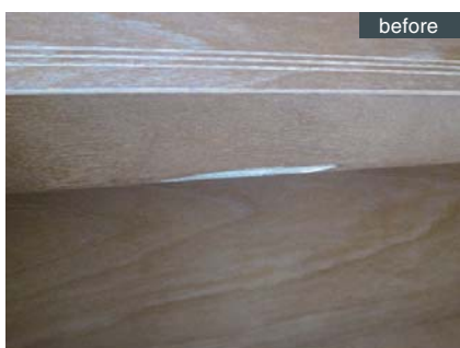
階段角傷補修
