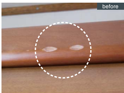
収納えぐれ傷補修
