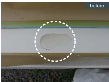
外部サッシ割れ補修1
