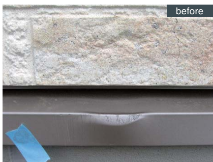
土台水切り補修
