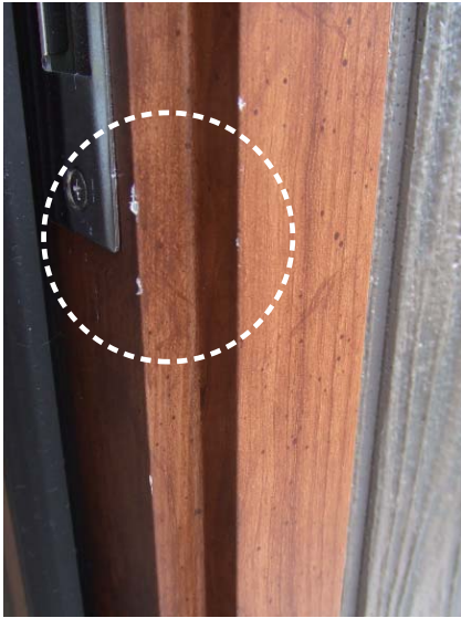
玄関ドアビス穴の補修
