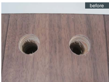
床配管穴補修
